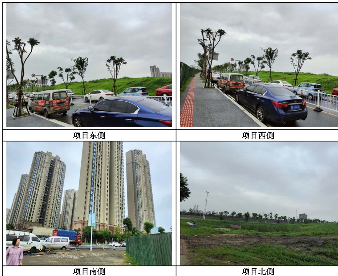
图 12 项目四周现状情况
